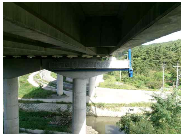
굴절점검차를 이용한 근접조사
