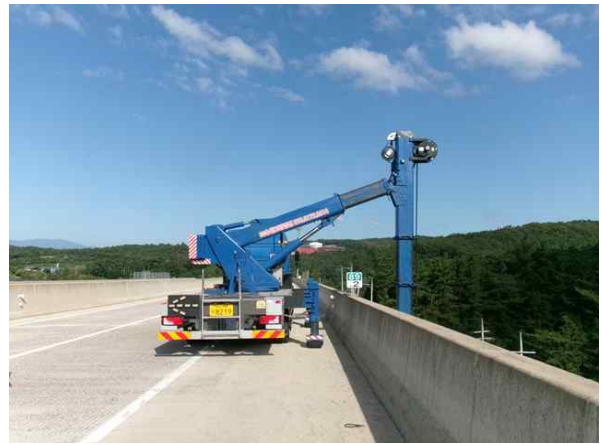
굴절점검차를 이용한 근접조사
