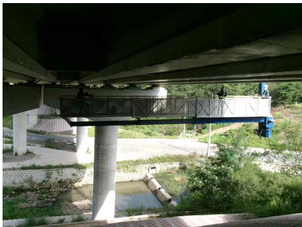
굴절점검차를 이용한 근접조사
